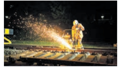
Laswerkzaamheden kunnen geluids- en lichtoverlast geven. Foto: ProRail B.V.
