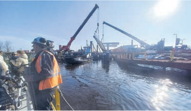
Werkzaamheden aan de nieuwe brug.
