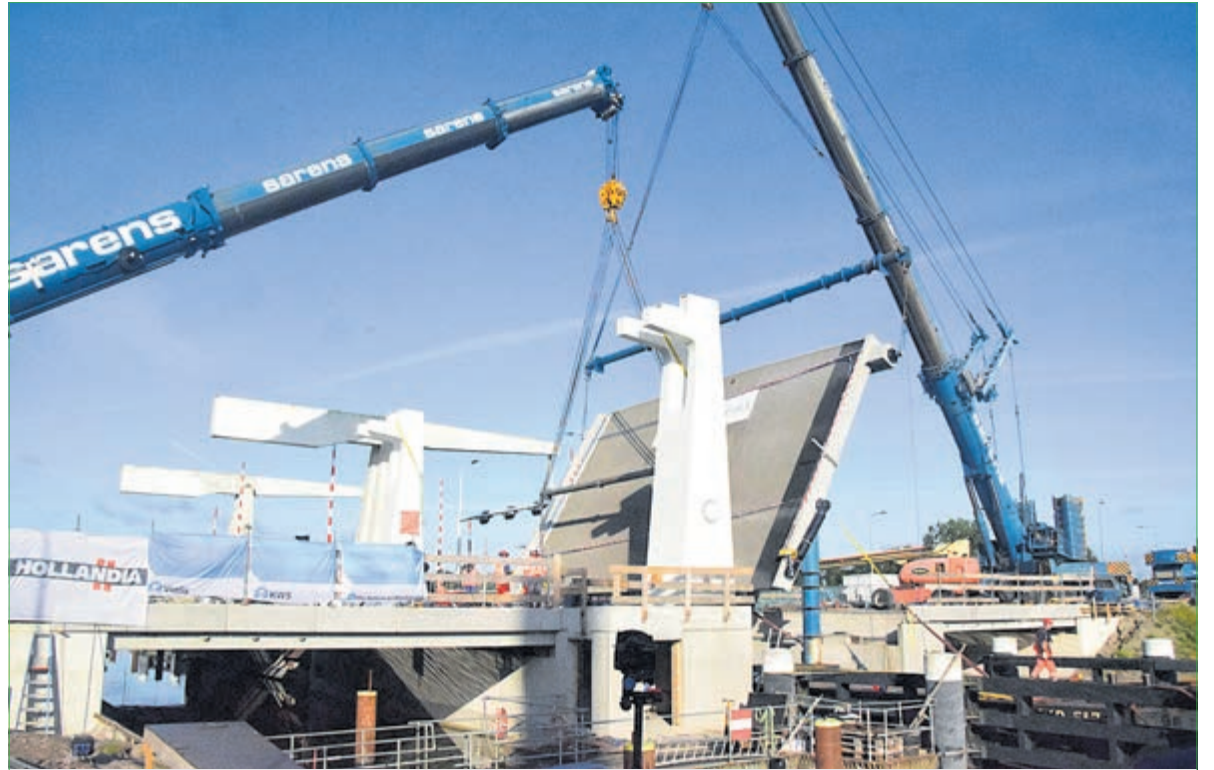
De brug stevig in de takels.
