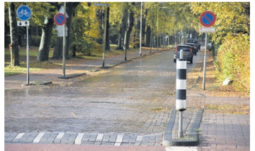
Huidige situatie Van Merlenlaan. Foto: Eric van Westerloo.
