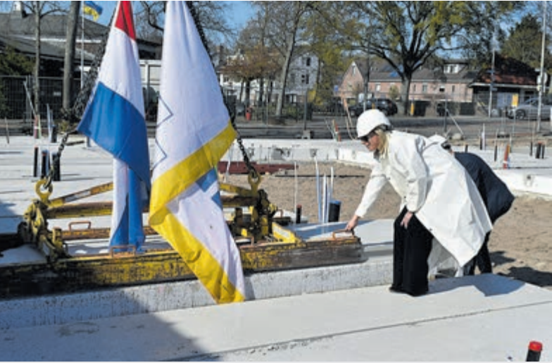
Wethouder Stam legt de betonplaat op zijn plek.
