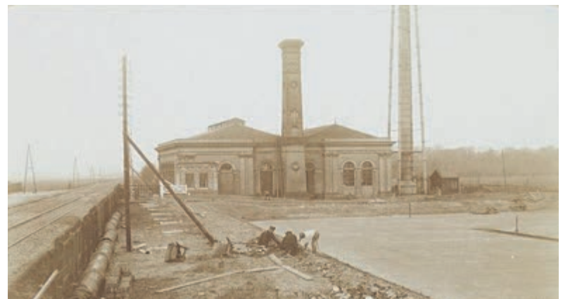
Pompstation in vroeger tijden. Foto aangeleverd door Landschap Noord-Holland.
